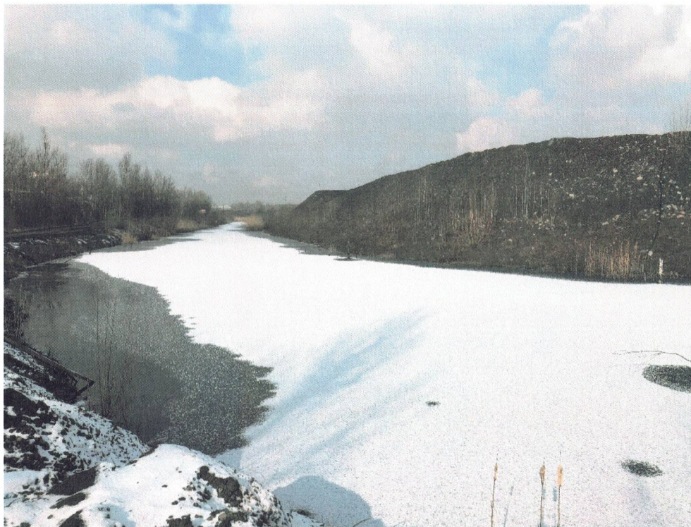
Vodní plocha (zátopa) v obvodovém příkopu kalové nádrže „G“
